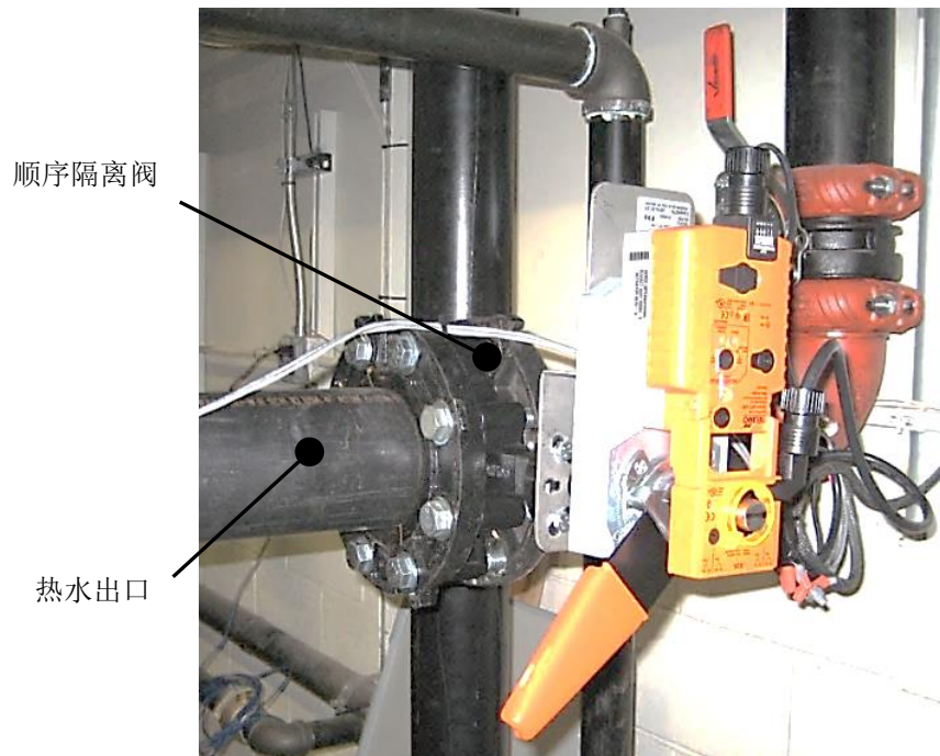
图 2-13：顺序隔离阀已经安装
